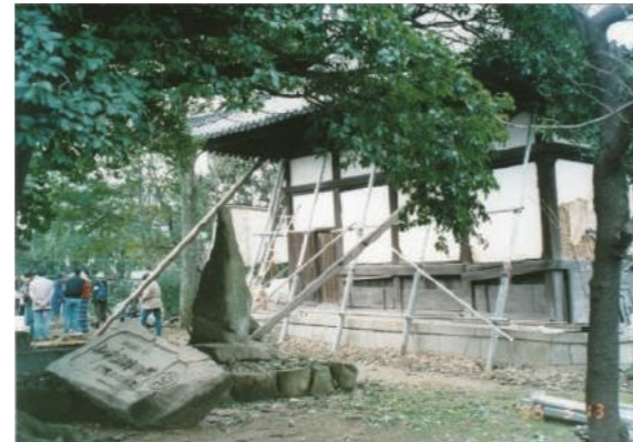
左側の石碑が倒れています。これは銭屋五兵衛の顕彰碑です。当時は薬師堂のすぐ横に建っており震災で倒れた状態でした。
