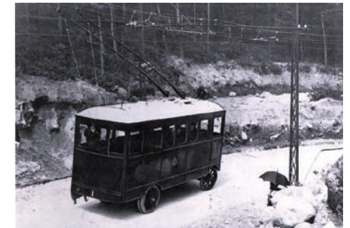
スプリングを強化する対策も効果が薄く、トロリーポールのはずれは日常茶番事だったようです。（車掌が窓から首を出してロープを引っ張り、ポールを直している様子）
