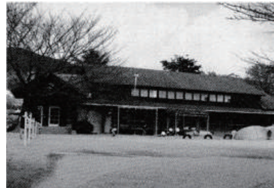
精常林間講堂（建て替え前の生成幼稚園）
