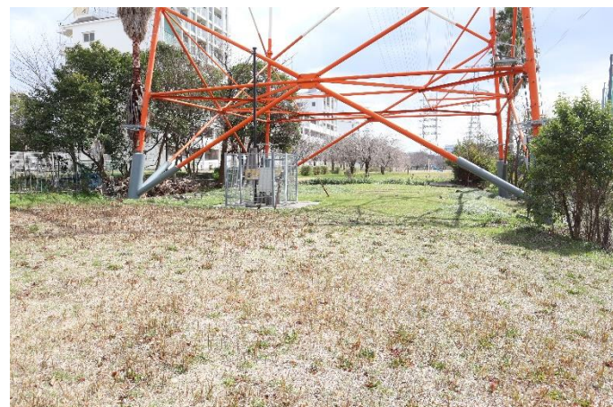
⑮同、鉄塔付近を撮影
