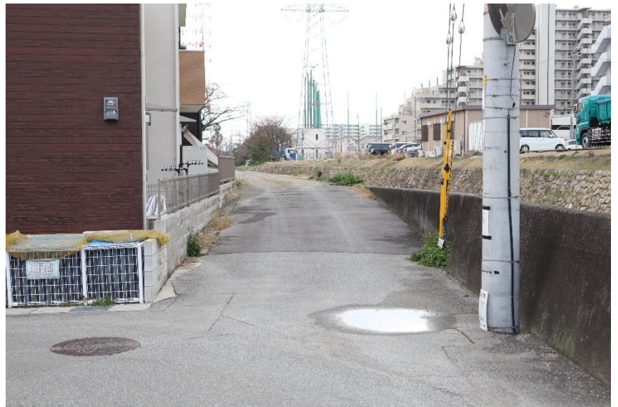
④川の護岸(立ち上がり)最終部を撮影
