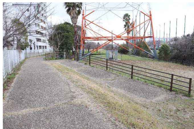
⑮スロープおよび鉄塔を撮影
