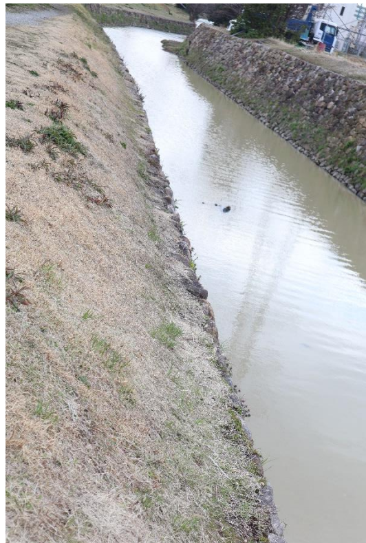
⑦同、土手部分を撮影
