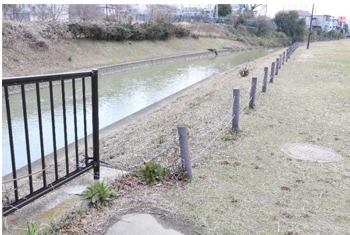
⑳橋の南西側落下防止柵を撮影
