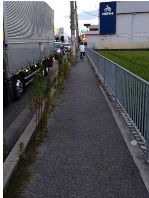
安倉交差点南より尼崎方向を撮影（西側歩道）
