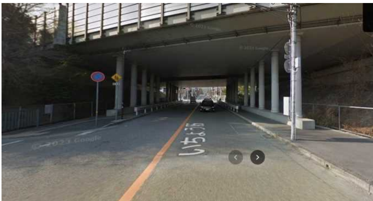
中国自動車道高架下（工事前）の様子
