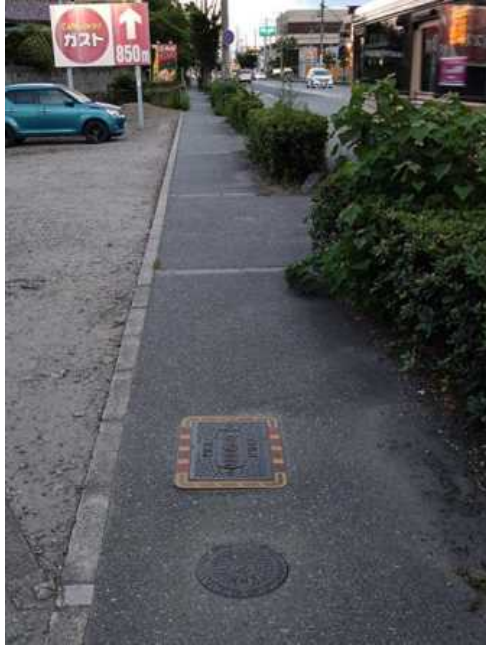
安倉交差点南より尼崎方向を撮影（東側歩道）
