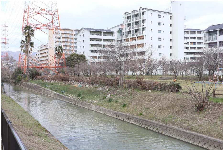
⑰護岸、土手部分を対岸より撮影
