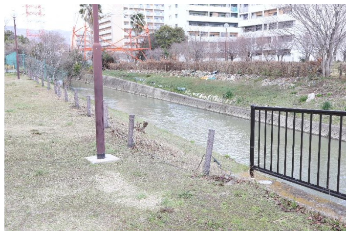
⑲橋の北西側落下防止柵を撮影
