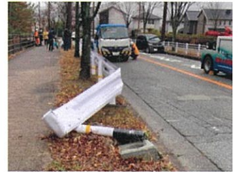
破損したガードレール
