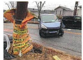
↑事故により破損した電柱
