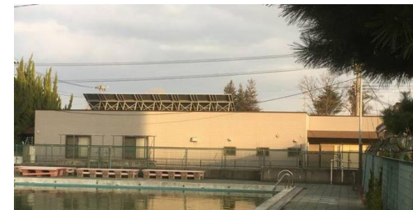
ウエル西山屋上の太陽光パネル
