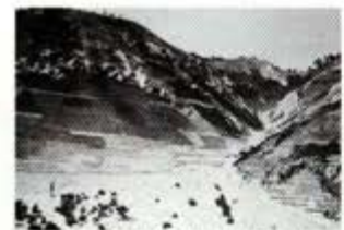
明治・大正時代に施工された山腹工事
