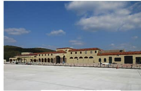
サービスエリア店舗棟
