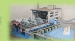
東浜第1・2・3ポンプ 第3ポンプ口径1800mm・第1口径2200mm
