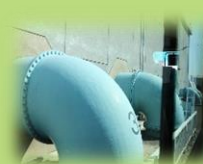
東浜第1・2・3ポンプ 第3ポンプ口径1800mm・第1口径2200mm
