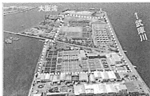
武庫川下流浄化センター
