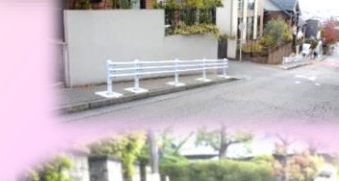
危険箇所改善 ↑南口河川敷階段改修 ↓宝梅坂ガードパイプ設置
