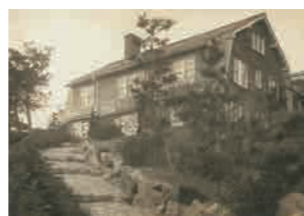
高碓記念館の竣工当時の外観
