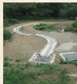
▲きずきの森に新設された開水路
