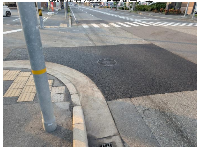
修繕状況(交差点北側マンホール)
