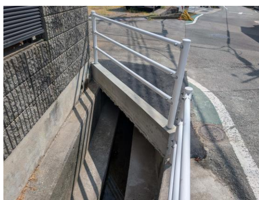
右写真:修理状況(工事後)
