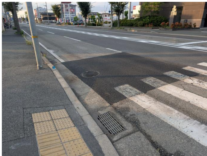
修繕状況(交差点南側マンホール)
