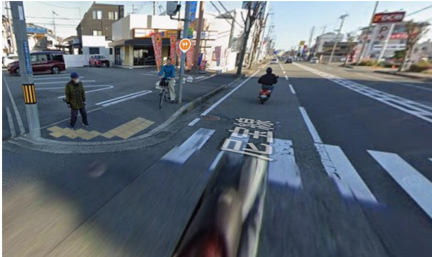
マンホールがへこんだ状況
